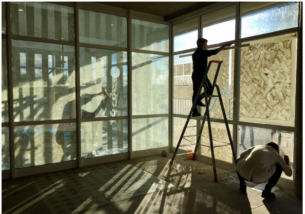
Etude au blanc de meudon, réalisée par les élèves de Mention complémentaire peinture et décoration et de Terminales CAP taille de pierre et CAP charpente
